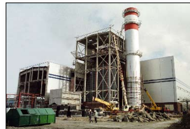
Końcowy montaż budynku kotła odzyskowego - listopad 2003 r. November 2003: final work on the construction of the heat recovery steam generator building
