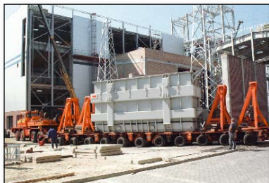
Transport transformatora bloku o wadzie prawie 200 ton - sierpień 2003 r. Delivery of a 200 ton block transformer - August 2003
