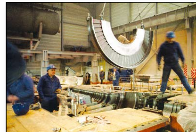
Montaż kierownic turbiny parowej BGP - październik 2003 r. October 2003: assembly of the steam turbine inlet guide vane (IGV)
