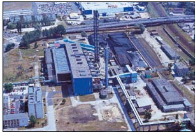
Widok Elektrociepłowni przed wybudowaniem BGP Elektrociepłownia before the Project start up
