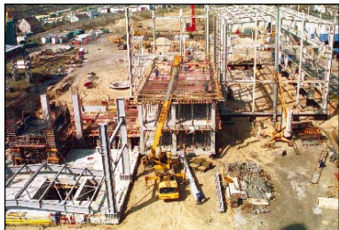
Początek montażu konstrukcji budynku turbiny parowej - kwiecień 2003 r. Construction of the steam turbine building - April 2003
