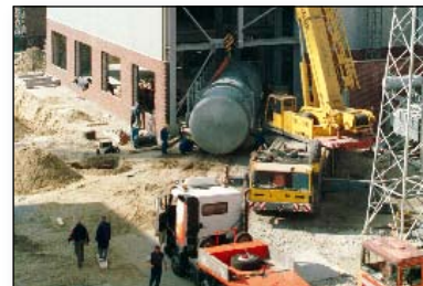
Montaż zbiornika wody zasilającej - sierpień 2003 r. August 2003: assembly of the supply water tank
