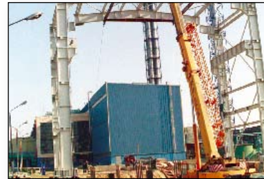
Początek montażu budynku turbiny gazowej - luty 2003 r. February 2003: beginning of the assembly of the gas turbine building
