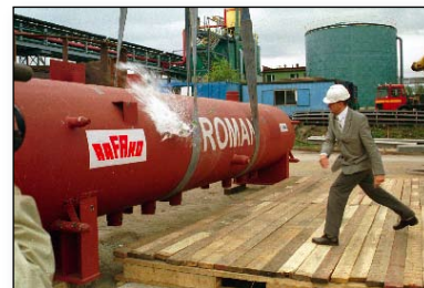
„Chrzest walczaków” - uroczystość kończąca montaż kotła odzyskowego BGP - 27 sierpnia 2003 r. August 27 th , 2003: celebrating the completion of the assembly of the heat recovery steam generator
