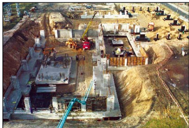
Prace fundamentowe na budowie BGP - styczeń 2003 r. First foundation - January 2003
